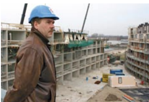
• Voor projectleider Marco Hendriks was het vanaf het begin al duidelijk dat gietbouw voor dit project de meest geschikte keuze was: "Kalkzandsteen valt af, omdat je met gietbouw veel meer vrijheid hebt met overkragingen. Verder haal je op dit project een hogere bouwsnelheid: we maken hier anderhalve woning per dag, dus zeven en een halve woning per week. De tunnelkisten zijn ook zeer maatvast. Daarnaast vind ik de eindkwaliteit voor de gebruiker hoger en kun je ook slanker bouwen. De wanden zijn hier 250 mm dik en de vloeren tussen de 210 en 280 mm."
