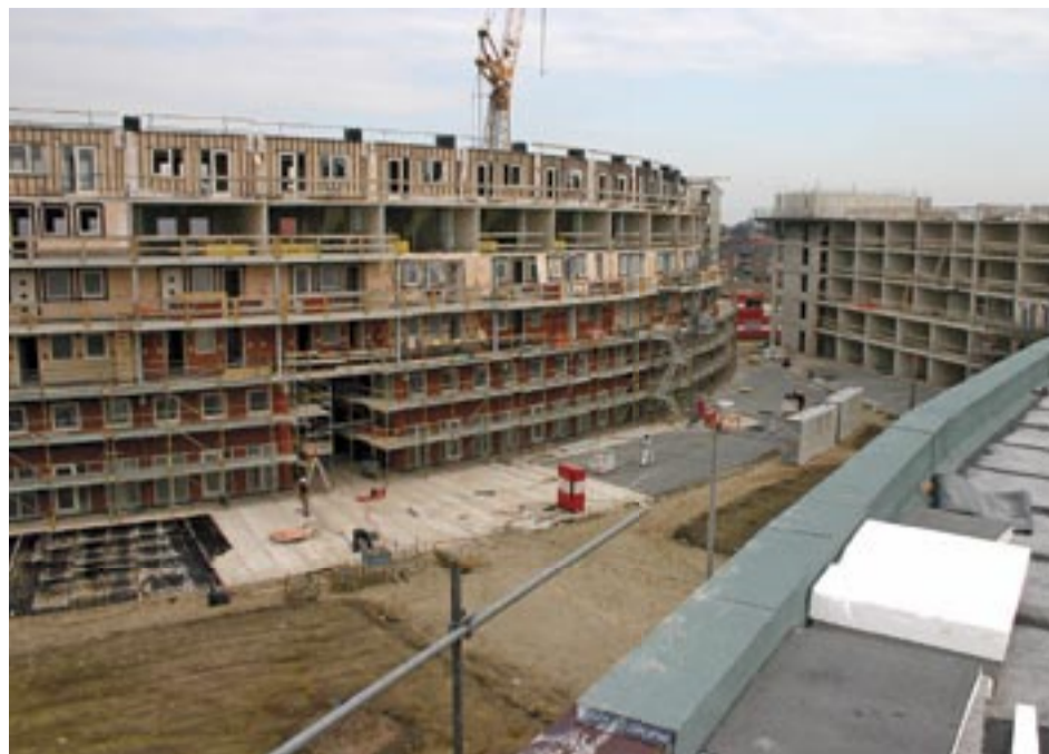
• Zicht op het binnenhof. De daken van de ondergrondse bergingen onder het binnenhof zijn reeds waterdicht gemaakt met bitumen.
