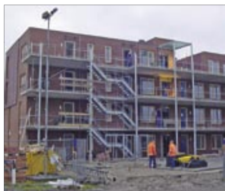
• Eerste geslaagde gietbouwproef in Avenhorn.
