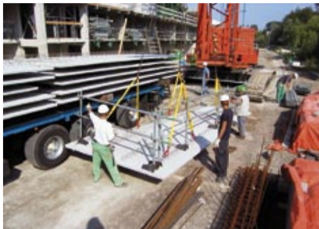
• De beste oplossing is het leuning- of hekwerk vooraf aan te brengen.
