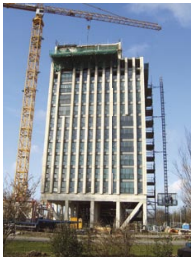
• De eerste toren in aanbouw.
