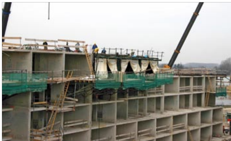
• Inzet van de drie tunnelkisten bij bouwdeel De Galon.
