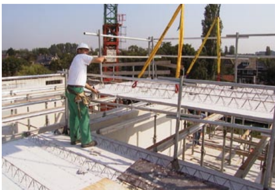
• De eerste plaat heeft leuning rondom, de volgende platen aan twee of drie zijden.
